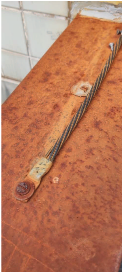
IMAGEM 1: CORROSÃO CABO DE CAPTAÇÃO
